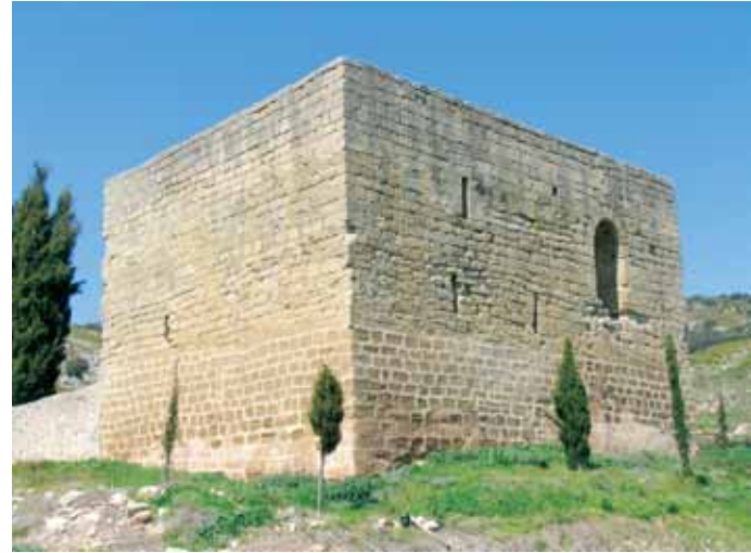
Exterior desde el Suroeste
