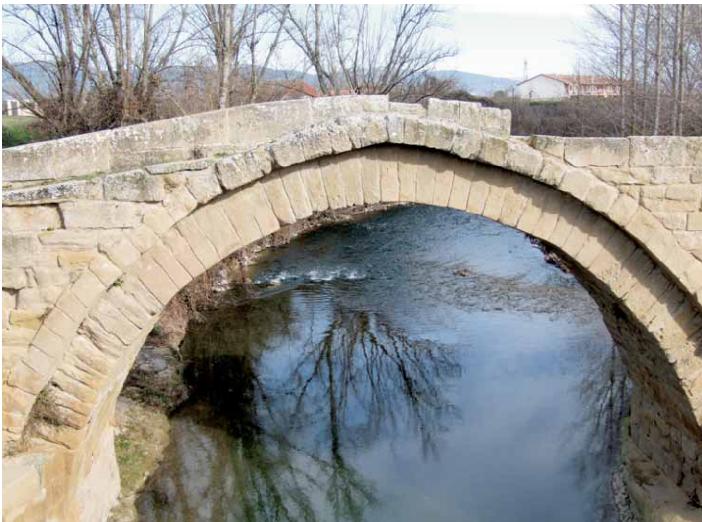
Detalle de la arcada central
