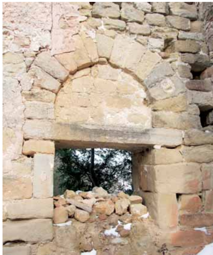
Restos del primitivo acceso en el muro norte
