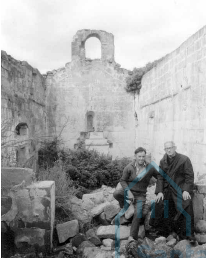
Aspecto general del interior hacia el Oeste
