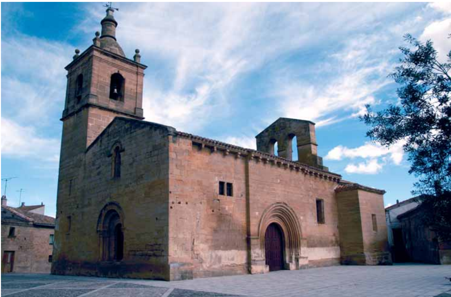
Vista exterior desde el Suroeste
