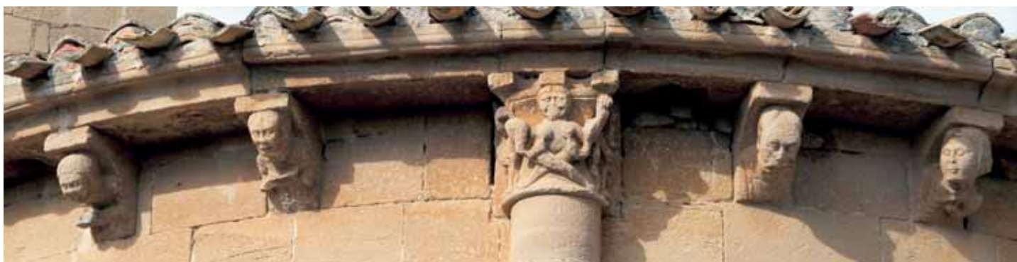
Arriba, canecillos de la nave, abajo, cornisa y canecillos del ábside
